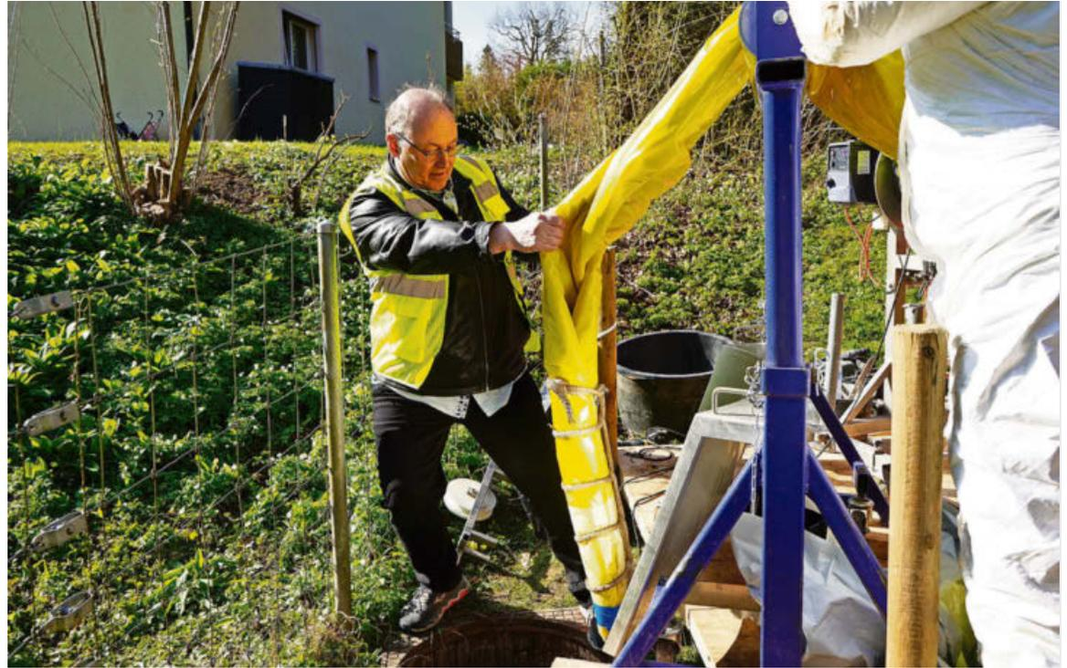
Der sogenannte Relining-Schlauch wird mit einer Seilwinde durch das Kanalrohr gezogen.
